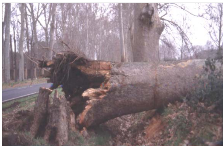
Árbol caído debido a un defecto en el
